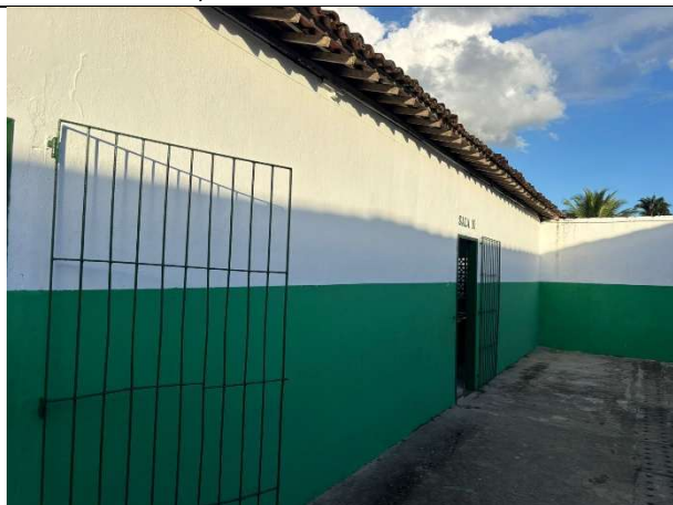
FOTO 5: Bloco existente que será reformado;
