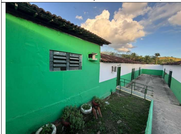
FOTO 9: Bloco existente que será reformado;
