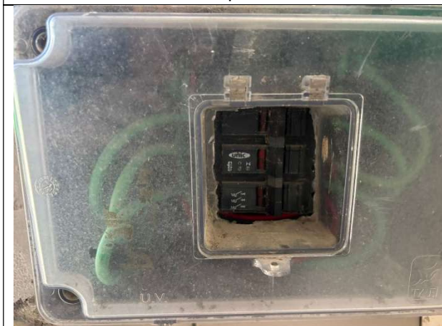
FOTO 11: Instalação elétrica existente;
