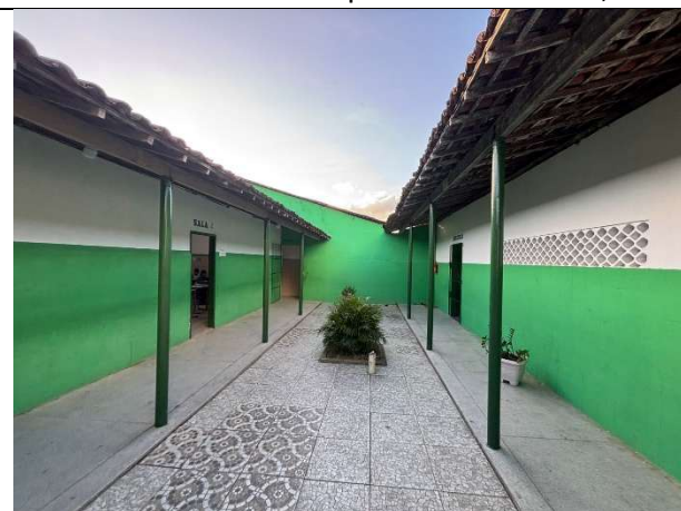
FOTO 10: Bloco existente que será reformado;
