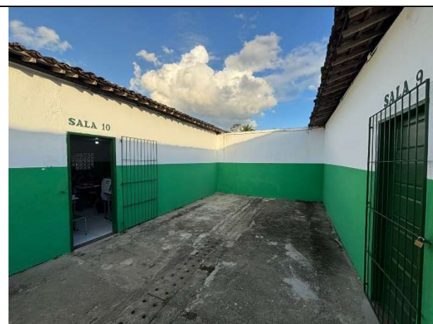
FOTO 8: Bloco existente que será reformado;
