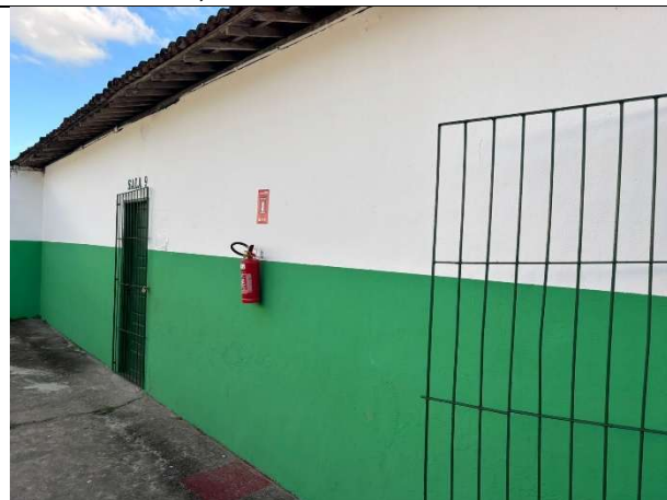
FOTO 6: Bloco existente que será reformado;
