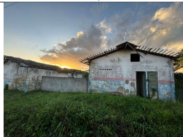
FOTO 12: Construção que vai ser demolida;
