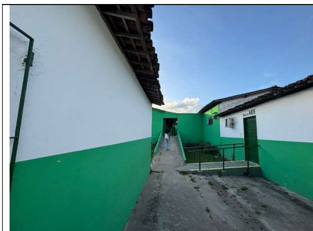
FOTO 7: Bloco existente que será reformado;
