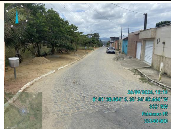
Foto 06: Pavimentação Asfáltica – Bairro: Quilombo I
