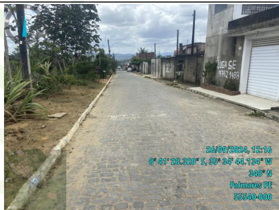
Foto 03: Pavimentação Asfáltica – Bairro: Quilombo I
