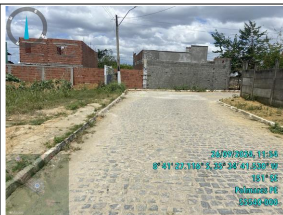
Foto 08: Pavimentação Asfáltica – Bairro: Quilombo I
