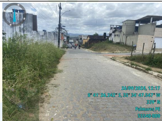
Foto 04: Pavimentação Asfáltica – Bairro: Quilombo I
