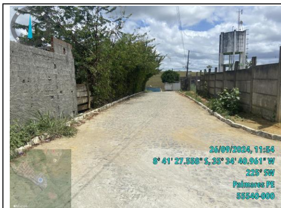
Foto 07: Pavimentação Asfáltica – Bairro: Quilombo I
