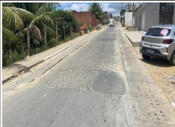
Foto 01: Pavimentação Asfáltica – Bairro: Quilombo I
