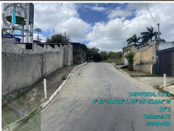
Foto 05: Pavimentação Asfáltica – Bairro: Quilombo I
