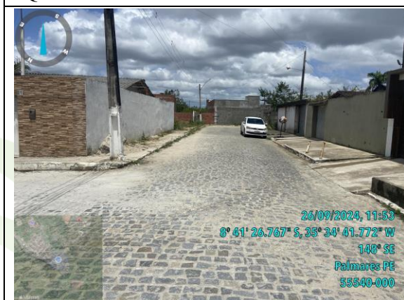
Foto 09: Pavimentação Asfáltica – Bairro: Quilombo I
